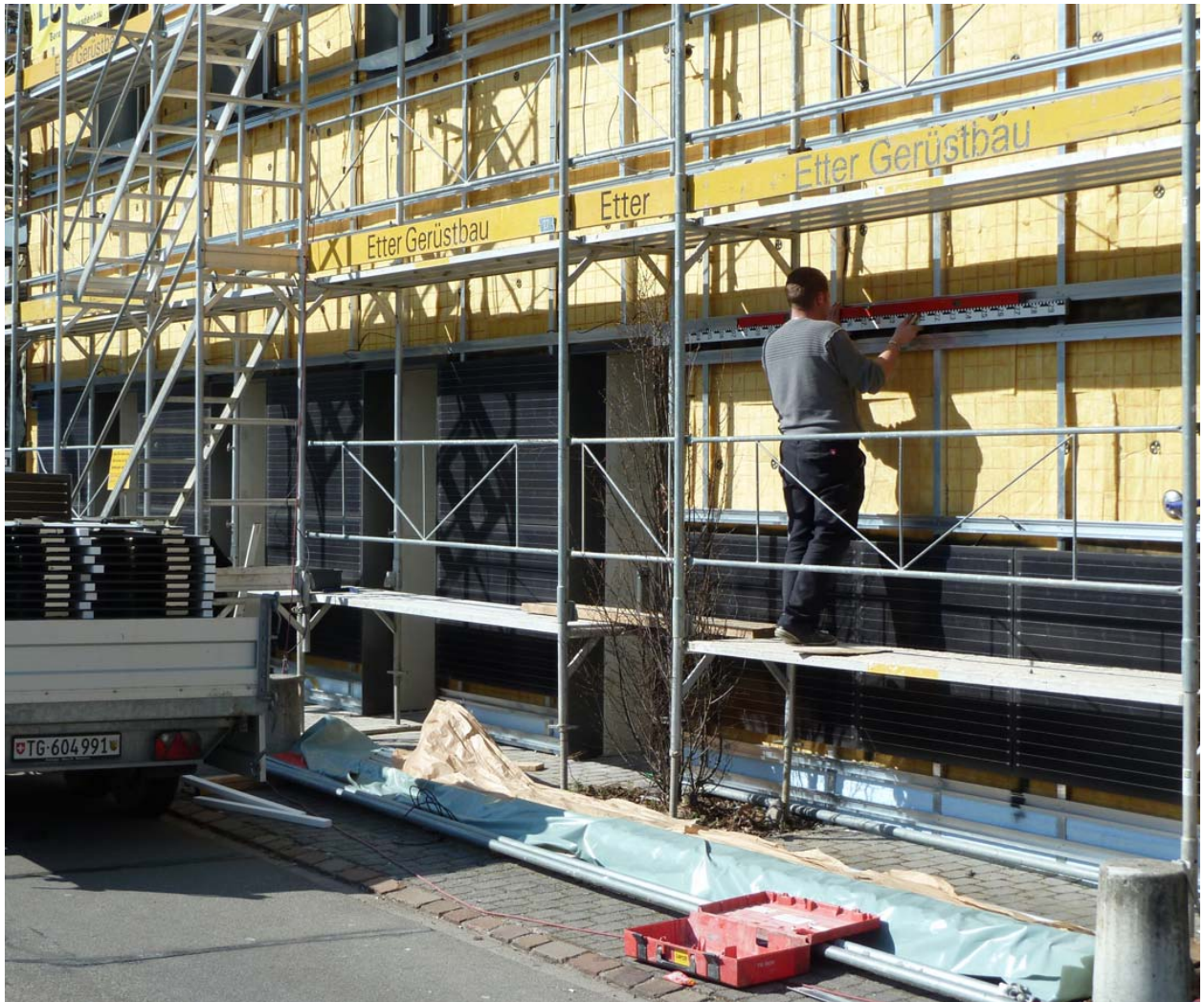
Gebäudehüllensanierung in Zusammenarbeit mit der Firma Lerch. Planung und Bauleitung Enersol.
