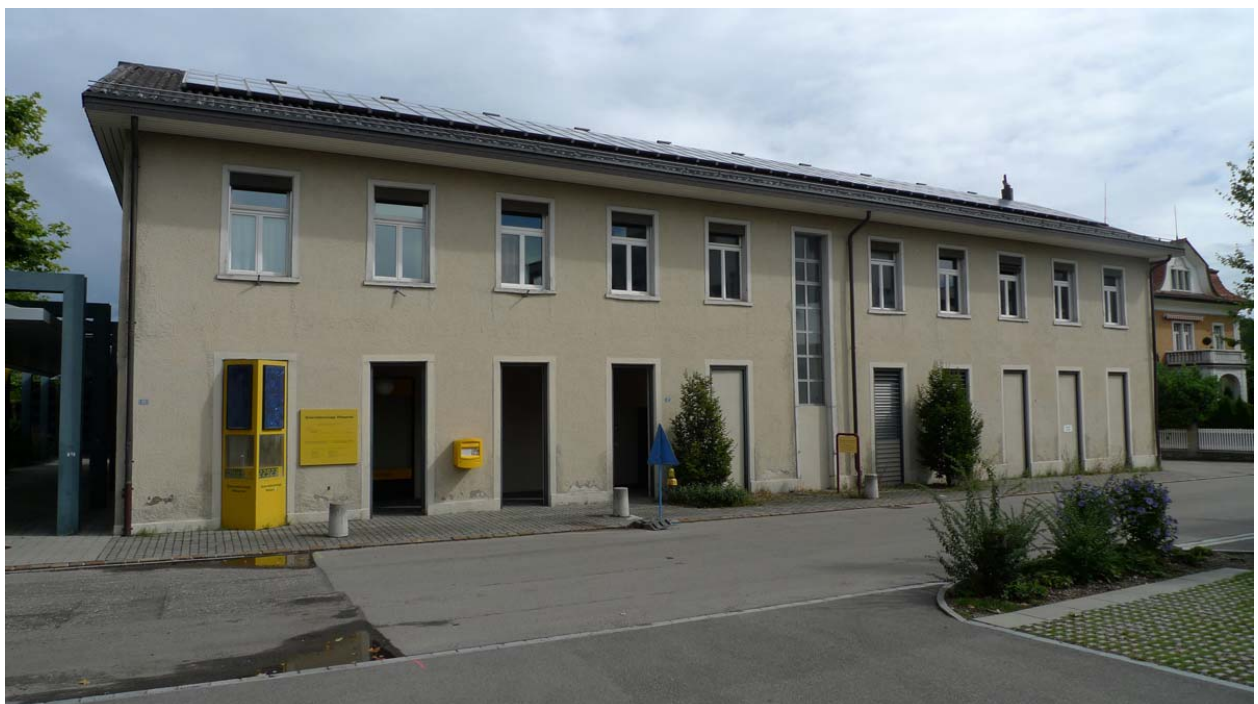
Gebäude vor dem Umbau
