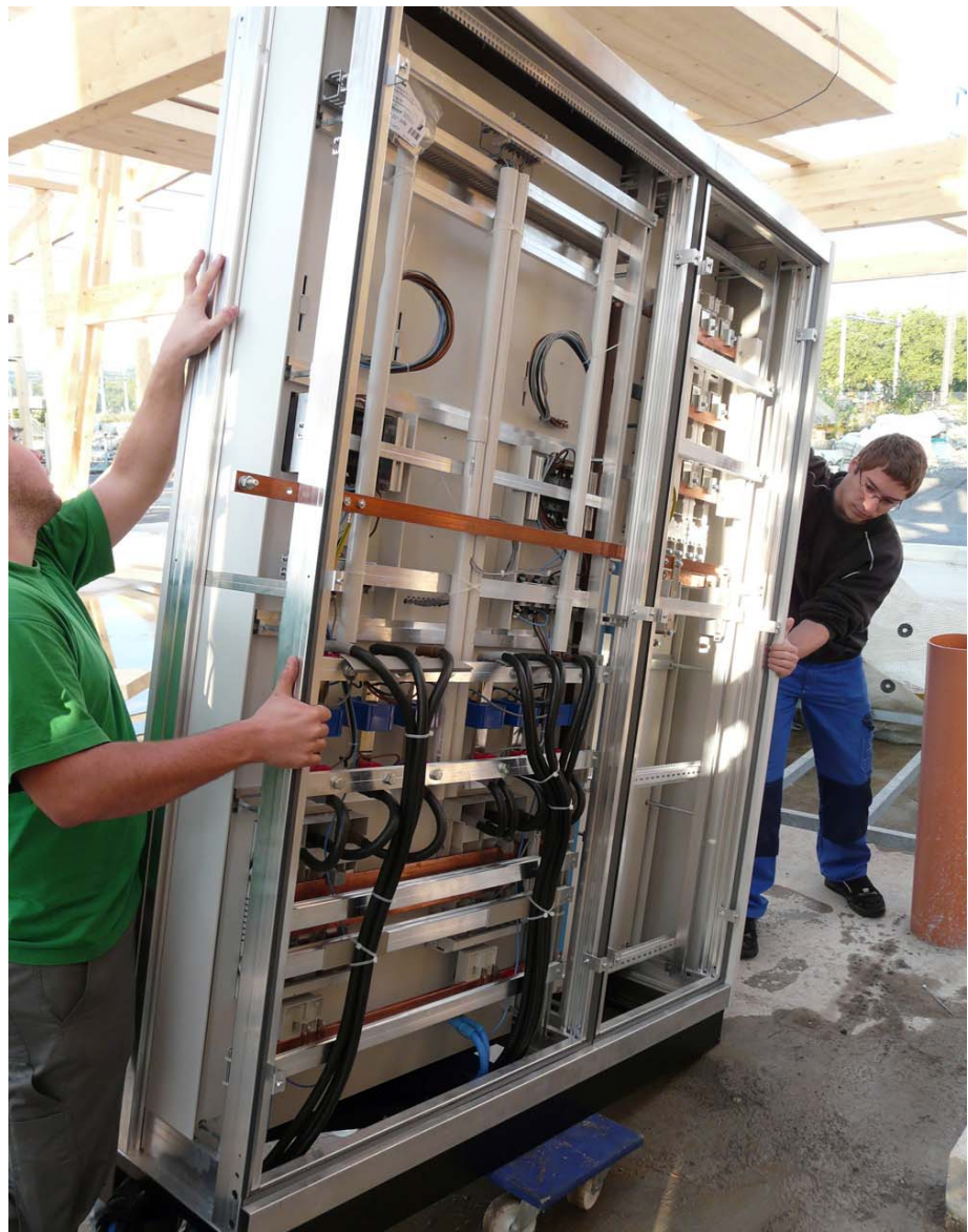
Der Schaltschrank mit den Energiezählern wird montiert
