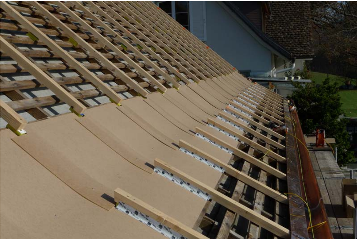
Luffführung der Zwangskühlung
